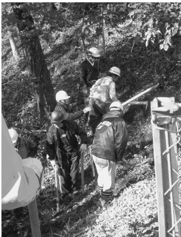
写真 学校林の安全確保のための作業 技術者、ボランティア、学校林関係者が協力して 安全な利用のためのインフラストラクチャを整 える。
