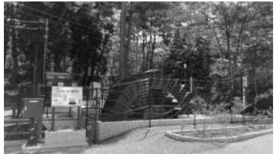
写真 7 県営ふじのしずく発電所 (2023 年新設)
